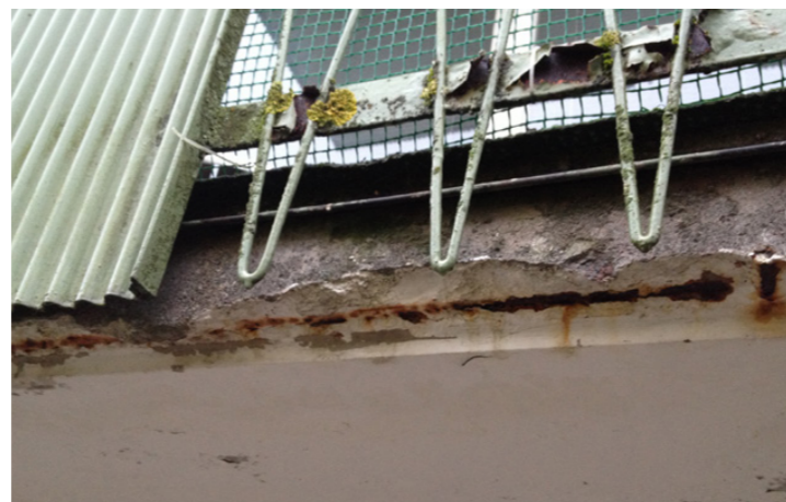
Här har betongen i balkongens framkant lossnat och kantarmeringen är synlig och rostskadad.
