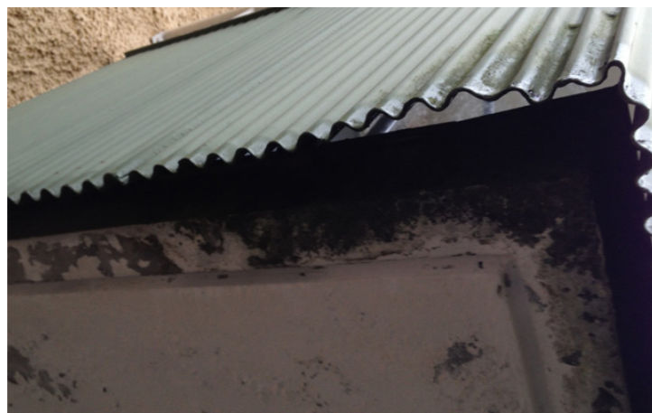
Fukt i betong och armering gör att betongen spjälkar loss, dvs. den spricker sönder. En fara om den faller ner...
