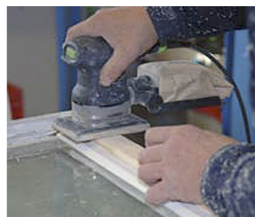
Eventuell reparation och träkomplettering (om delar av bågen är ansatt av t.ex. röta), spackling och slipning.
