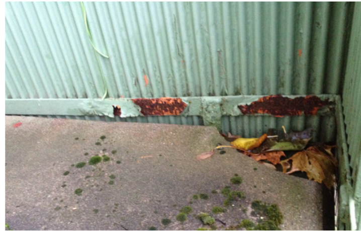
Balkongens övre betongskikt är sprucket och vatten letar sig ner mot armeringen som finns i det nedre betonglagret.
