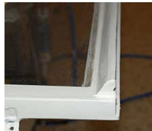
12-13 Bågen målas och monteras därefter åter på innerkarm.
