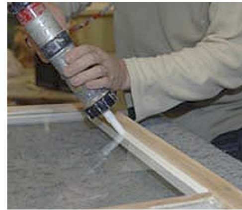
9 Energiglas monteras och kittas.
