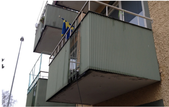
Balkongerna har sett sina bästa dagar. Fukt tar sig in i betongen och får armeringen att rosta och betongen spricker.
