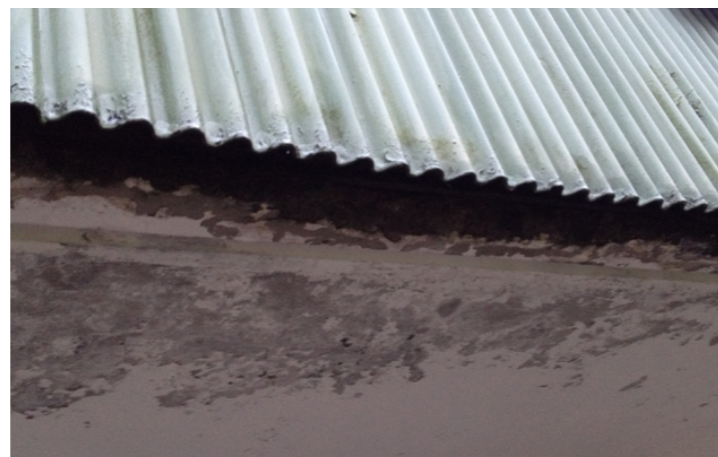
Att färgen på betongplattan flagar och att saltavlagringar syns visar också att betongen är fuktskadad.
