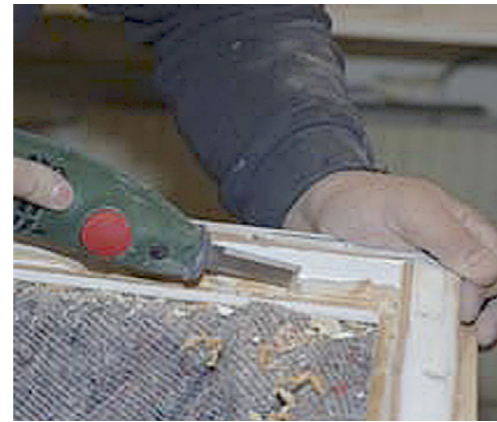
8 Kitt och glas avlägsnas. Bågen renas, slipas ren och fuktkontrolleras.
